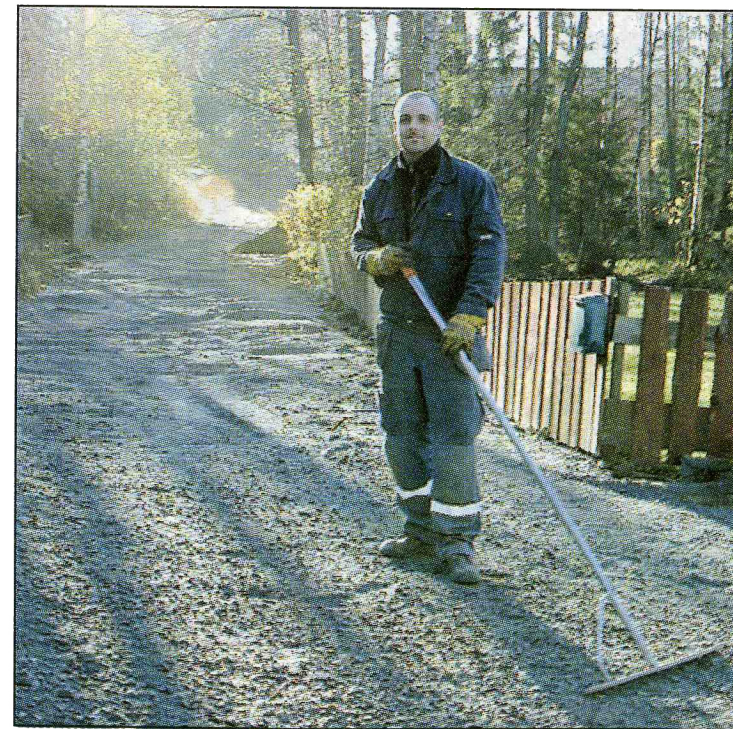
Peter Flodin fra Samuel Miniprojekt raker den såkalte «nulltjuen» (grusen) utover den flate delen av Seterveien. Han regner med at alle tre veier er ferdige med det groveste før vinteren.
